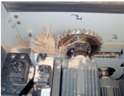
Des languettes bouchent l'aspiration – Risque d'incendie dû aux frottements de l'outil en rotation.
